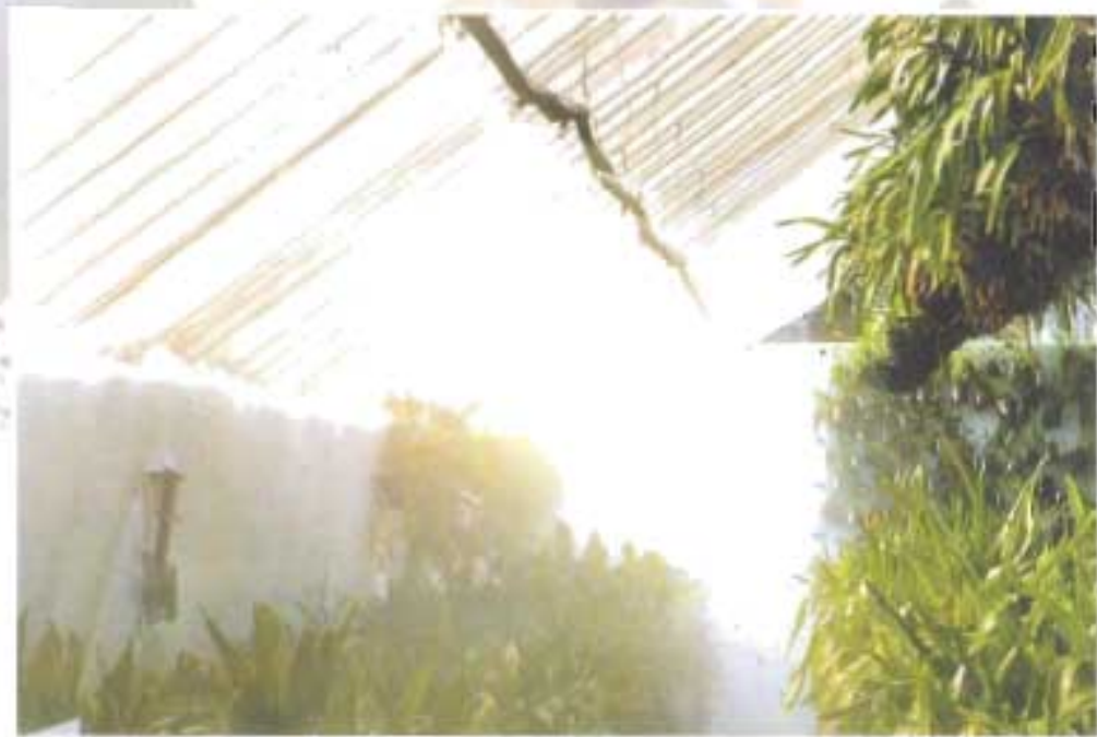
Một hệ thống phun hơi sương trên trần nhà
